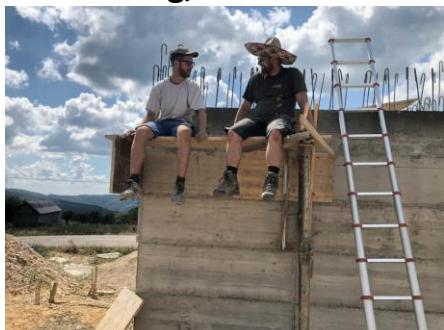
Die Arbeiten beim Ausgleichsreservoir sind nicht mehr allzugross. Am Donnerstag wird von drei Personen wiederum ausgeschalt und das Material gewaschen. Außerdem wird ein Gerüst gebaut, damit am nächsten Tag die Innenschalung besser aufgebaut werden kann.
