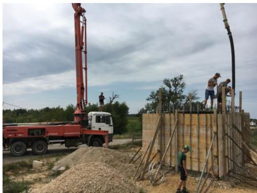
Auf dem Ausgleichsreservoir wird ein provisorisches Gerüst erstellt, damit man den Beton hineinpumpen und vibrieren kann. Mit etwas Verspätung kommt dann die Betonpumpe und der Trommelmischer zur Baustelle und liefern den bestellten Beton. Nach rund einer halben Stunde ist die Sache erledigt. Die beiden Lastwagen fahren wieder ab und die restlichen Personen waschen die Schaltfeln, um das nachträgliche Putzen zu erleichtern. Auch das
