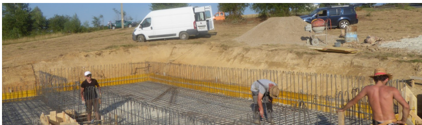
Armierung des zweiten Trinkwasserreservoirs
