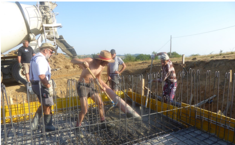
Betonieren der Bodenplatte des zweiten Trinkwasserreservoirs
