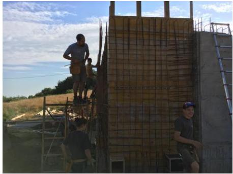
Am **Montag** geht es zurück auf die Baustellen. Auf der grösseren Baustelle werden die Armierungseisen fertig gelegt und die Wände zugeschalt. Parallel dazu beginnt ein Teil der Gruppe aus Appenzell mit dem Bau für das Stara Huta Reservoir. Dafür wird die Bodenplatte mit Schalatfeln geschalt, einige Aushube etwas korrigiert und die Aussparung für den Schacht vorbereitet.
