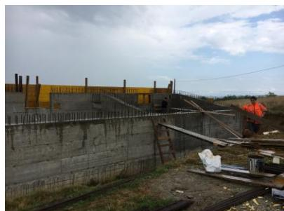
Bei der grösseren Baustelle sind verschiedene Arbeiten von Nöten. Einige beginnen mit Ausschalen der bereits erstellten Mauern, andere die Wände des Technikraums zu schalen und die Armierungseisen zu legen. Trotz kurzzeitigem Regenschauer wird fleissig gearbeitet.
