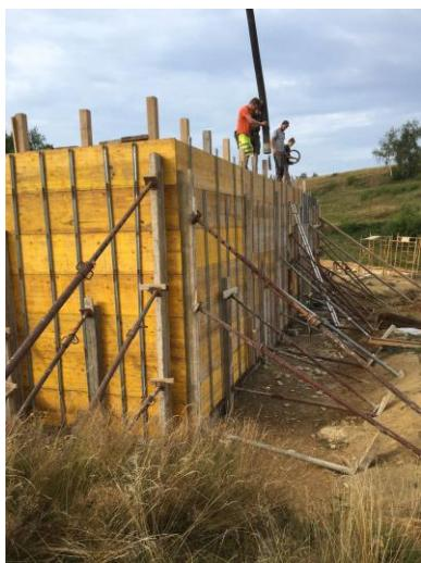
Betonpumpe gearbeitet, damit es etwas zügiger vorwärts geht. Nur bricht während des Betonierens ein Brett weg, so dass zusätzlich geschaufelt werden muss. Mit solchen Zwischenfällen muss gerechnet werden, aber das Team hat gut darauf reagiert. Als das Betonieren beendet ist, wird noch das Rohr und der Schacht für den Überlauf gesetzt.
