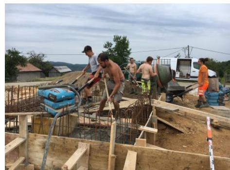
und Wasser befüllt werden. Weiter geht der gemischte Beton in Schubkarren, welche über Rampen in die Schalung transportiert werden. Zuletzt wird geschaut, dass der Beton gut verteilt, vibriert ist und die richtige Höhe erreicht. Nach gut 3 Stunden ist die 3m x 5m x 35cm Bodenplatte mit etwa 5 m<sup>3</sup> Beton gefüllt.
