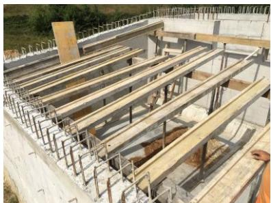
Letzter Tag, **Freitag**. Die Bodenplatte konnte über Nacht ziehen und wird deshalb bereits ausgeschalt. Der Rand wird noch mit Schotter versehen und alles aufgeräumt, dann ist die Baustelle für die Hilfstruppe auch schon abgeschlossen. Beim grossen Reservoir wird noch mit der Deckenschalung begonnen, doch vor allem die Putzarbeiten sind an diesem Tag im Vordergrund. Gebrauchtes Material und Werkzeuge, Autos und der Bus
