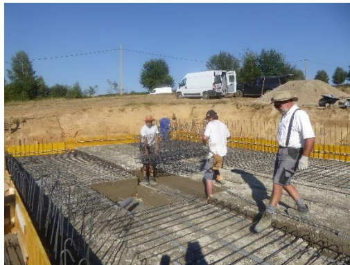
Die Armierungseisen hieften wir in den Schacht.
