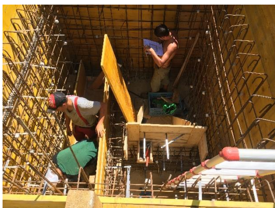
Einbauen der Armierungseisen in der Brunnenstube.
