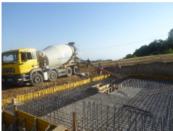
Betonieren des Technikraums.
