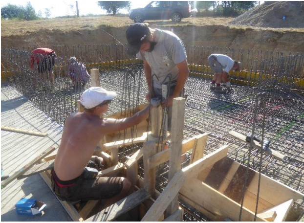
Bau der Schalung zwischen dem Technikraum und den Wasserbecken.
