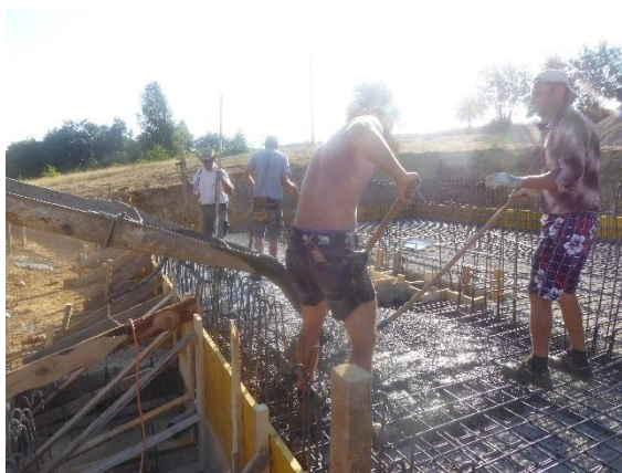
Verteilen des Betons.
