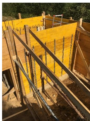
Versperrung und Verschwenkung. Genaues arbeiten ist gefragt.
