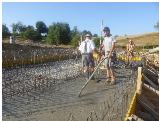
Der Beton musste gut vibriert werden, damit er dicht wird.
