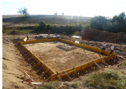
Die Schalung für die Bodenplatte des Reservoirs.
