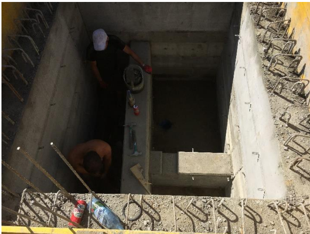
Demontage der inneren Schalung.
