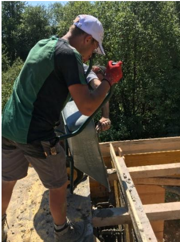
Den Beton in die Schalung kippen.
