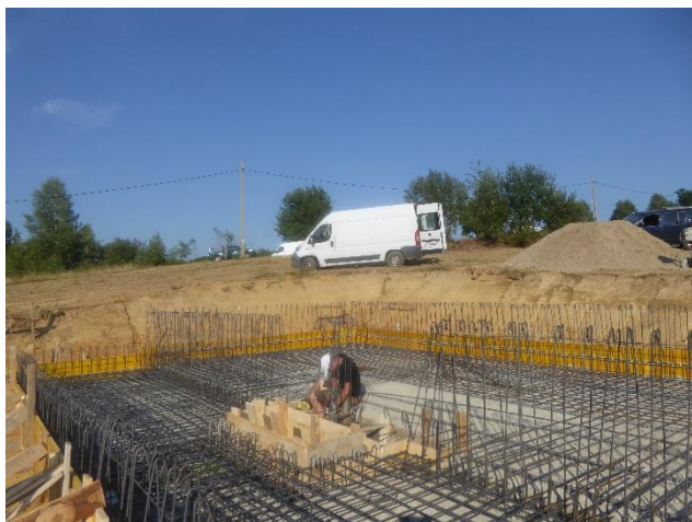
Einbauen der weiteren Armierungseisen beim Reservoir.
