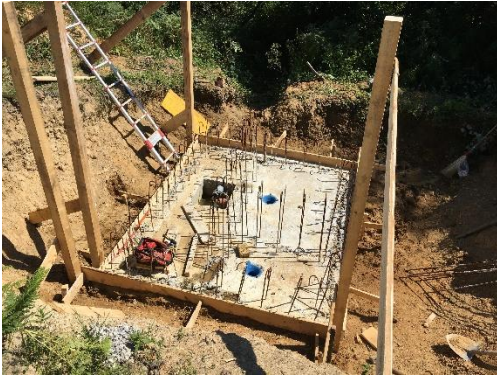
Die bereits erstellte Bodenplatte der Brunnenstube.
