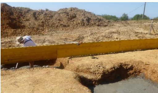
Magerbeton wurde in den Schächten verteilt.
